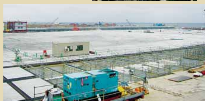
工事中の羽田空港D滑走路（2009年撮影）
