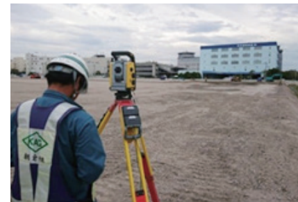
▲駐車場整備の工事にて、IOT 施工を実施。施工時間の短縮が図られ、労力が軽減され働き方を変えられます。
